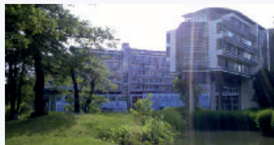
Zukünftig auch für Verbandsveranstaltungen vorgesehen – seit Juni das neue Domizil des Landesverbandes am Potsdamer Luftschiffhafen
